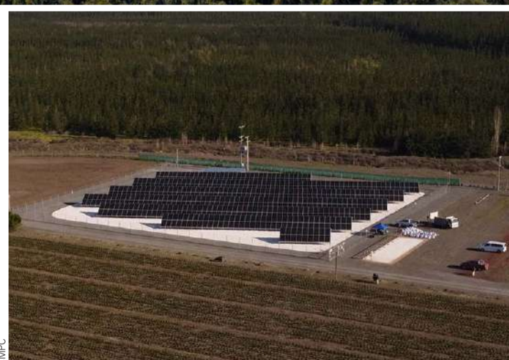
Recientemente, CMPC comenzó con la instalación de una red fotovoltaica que permitirá ahorrar unos US$ 57 mil anuales.
